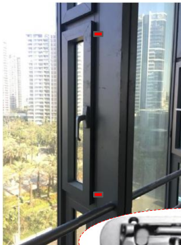
插销压式防台风 锁扣安装示意
