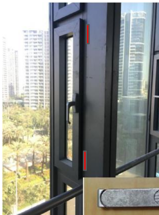
插销压式防台风 锁扣安装示意
